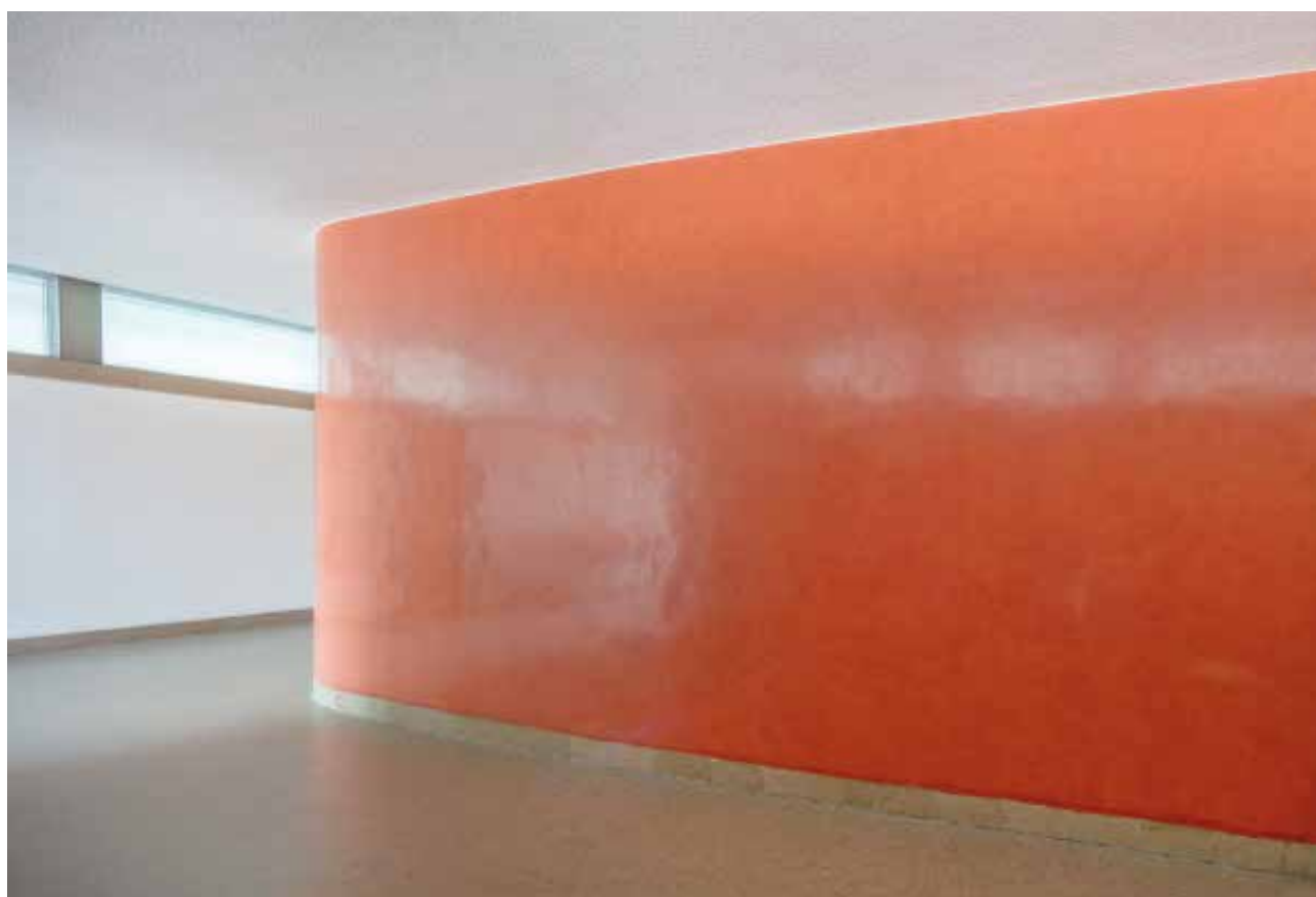
Servicekern mit rot eingefärbtem Stuccolustro
