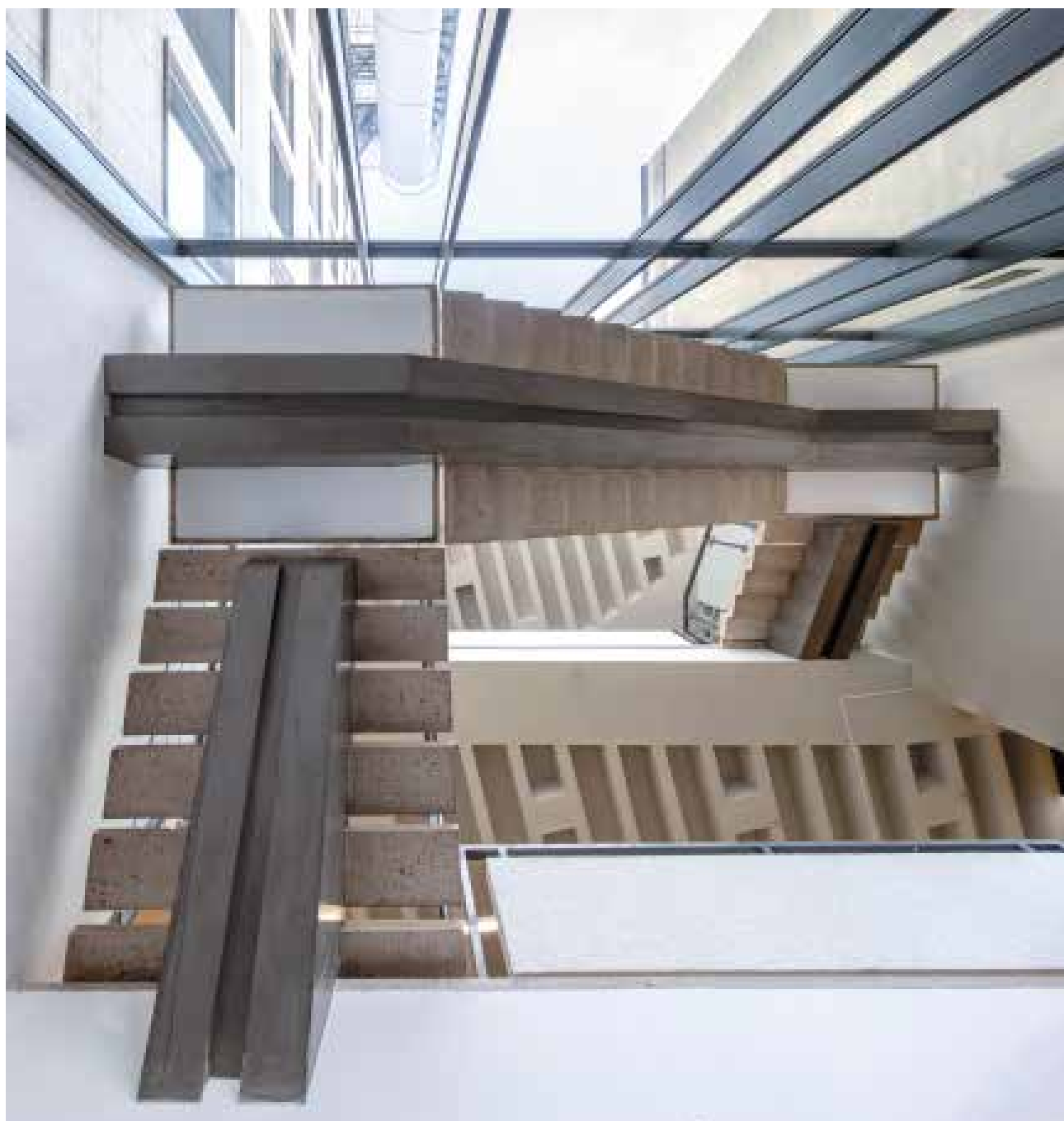
Treppenkonstruktion im Haupttreppenhaus
