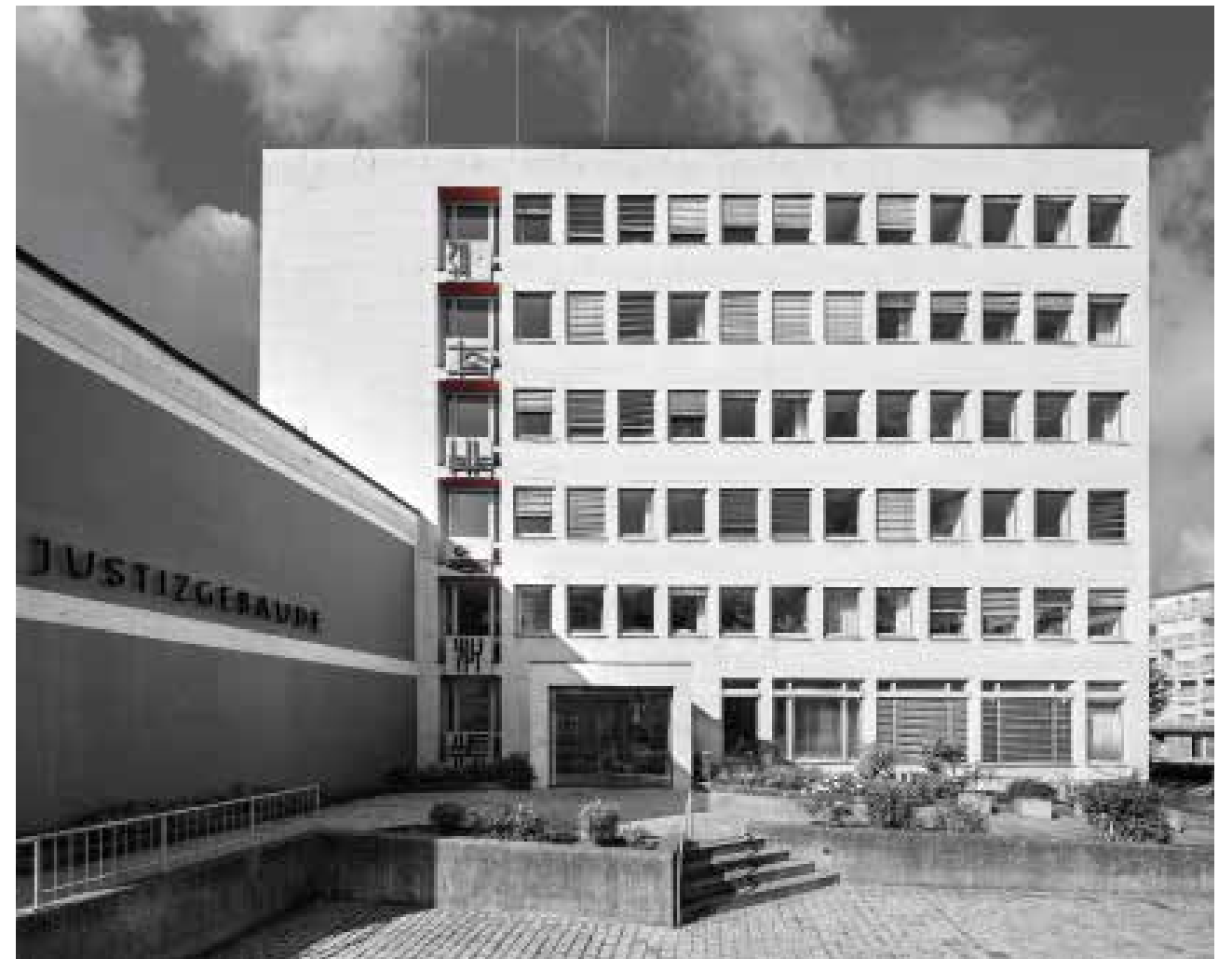
Justizgebäude Aschaffenburg, Verwaltungsgebäudes Erthalstraße
