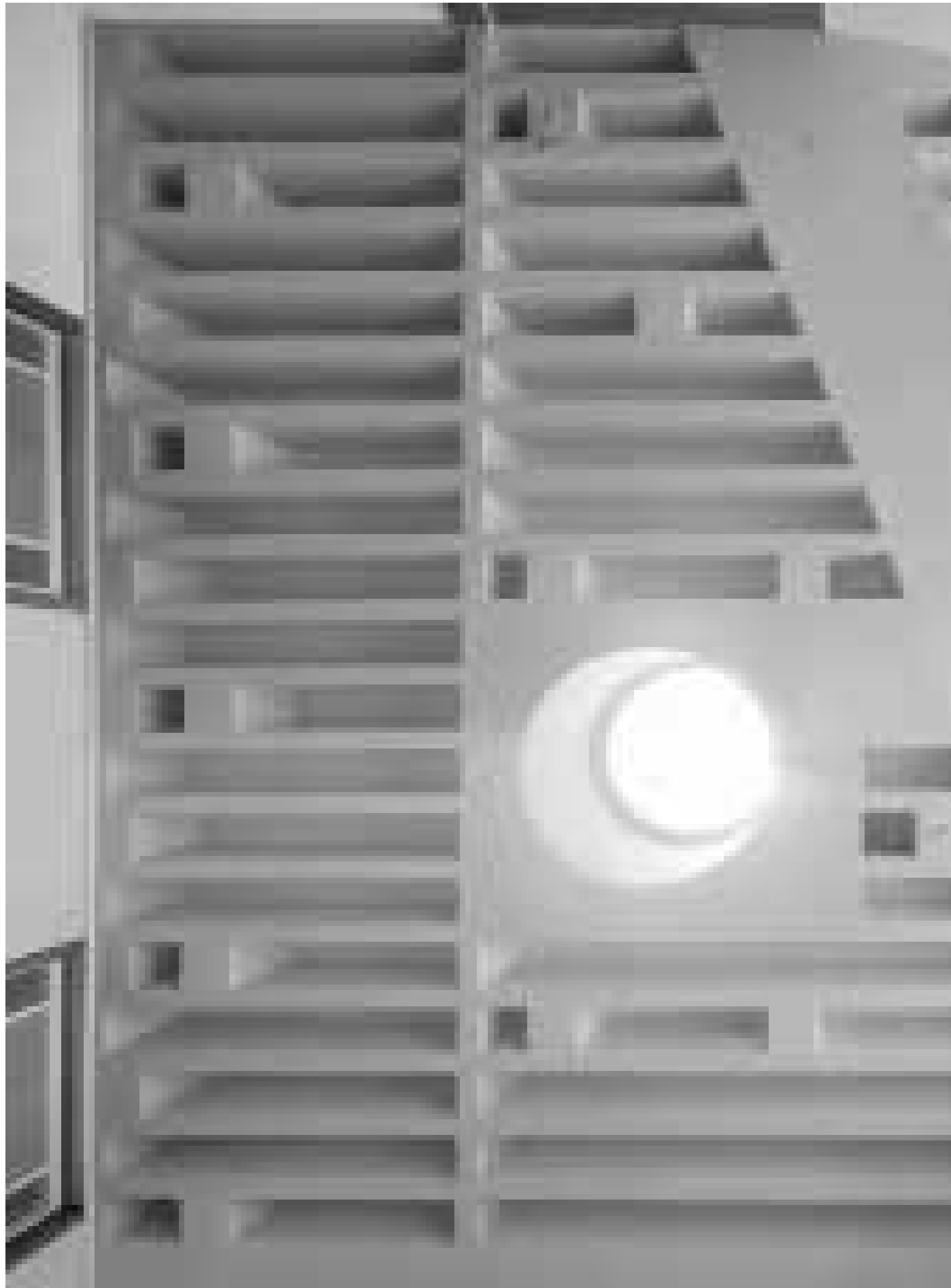
Stahlbetonrippendecke mit Oberlicht im Haupttreppenhaus
