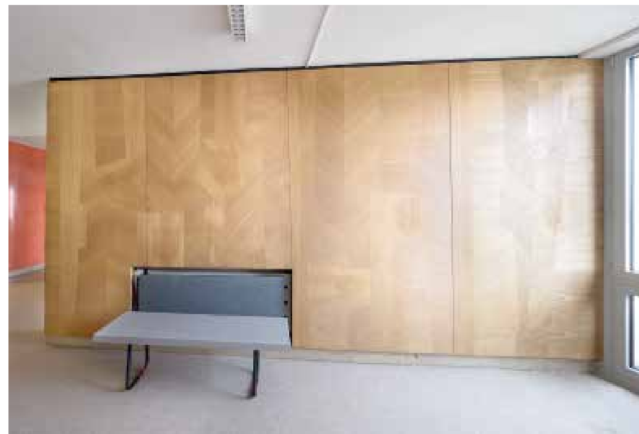
Wandverkleidung als «Furniermosaik» am Flurende, zweites von insgesamt vier Motiven mit Bank vor Heizkörperverkleidung aus Metall
