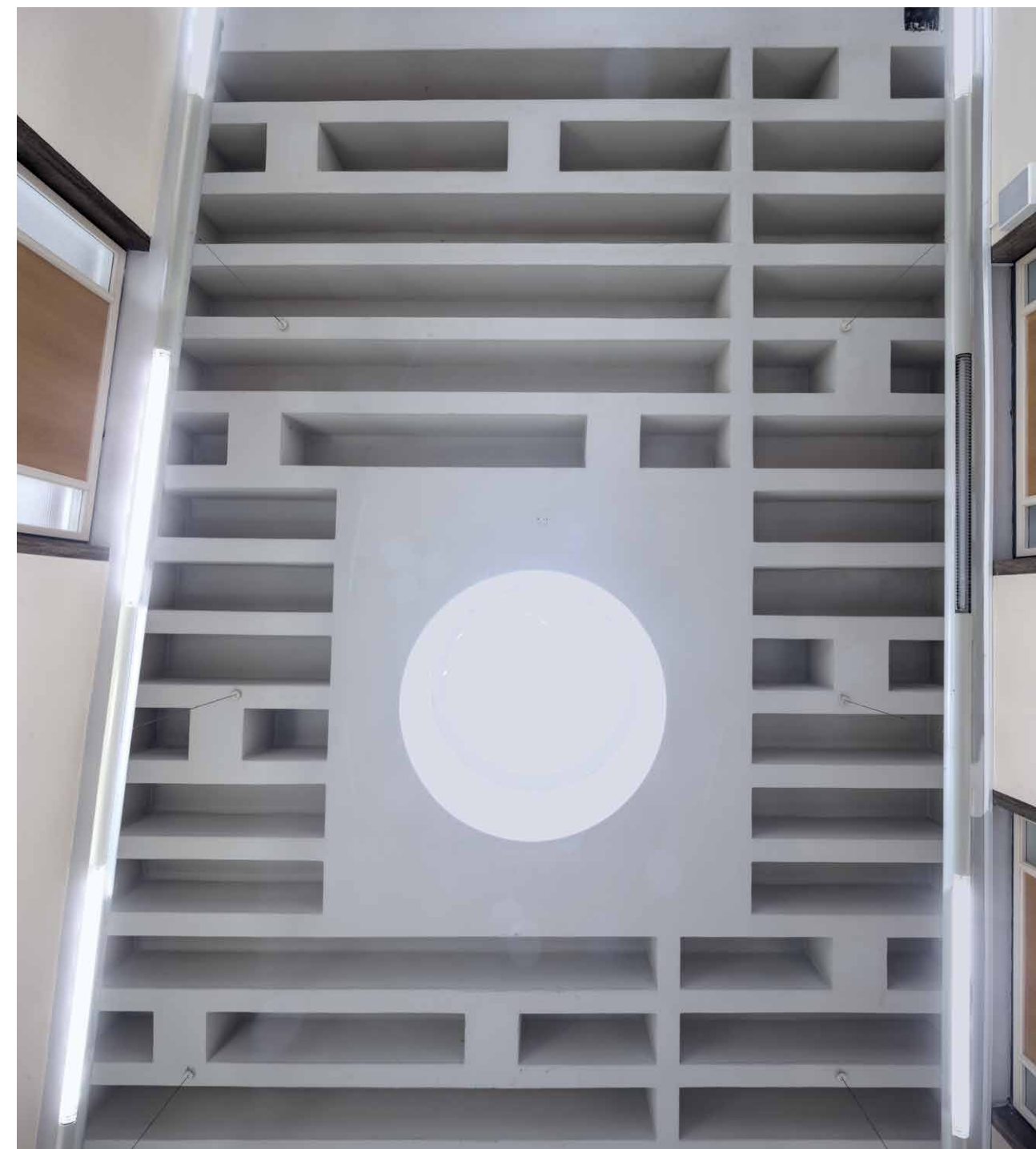
Stahlbetonrippendecke mit Oberlicht im Haupttreppenhaus
