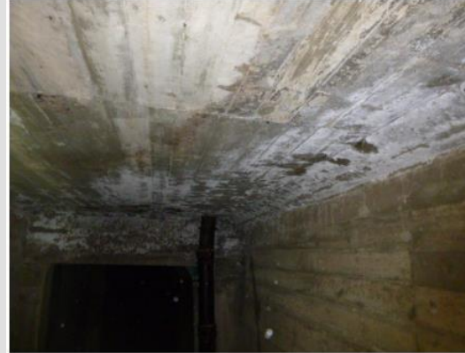
2020_H_FAHRBAHNPLATTE AUSBLÜHUNGEN
